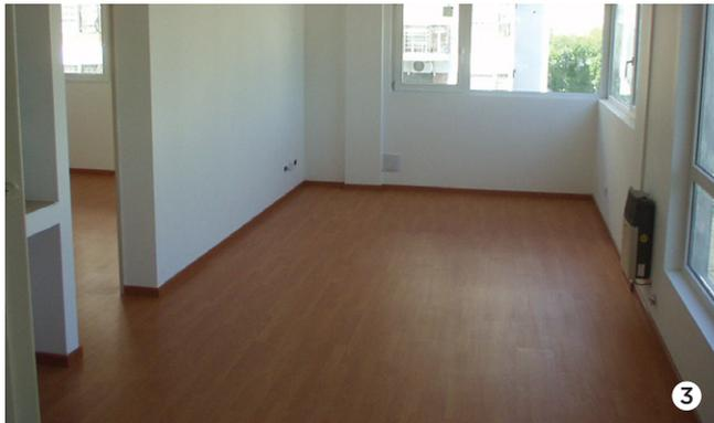
3. Concluir con una carpeta de nivelación y un solado colocado de manera tradicional. Por último colocar el zócalo dejando una junta con el piso. Completar empleando algún elemento elástico (sellador).
