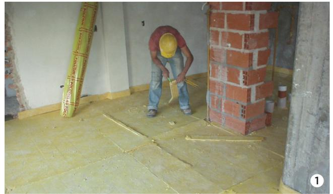
1. Colocar Panel PF cubriendo toda la superficie de la losa y los laterales conformando un zócalo con el mismo panel hasta la altura del nivel de piso terminado. Pegar dicho zócalo con adhesivo de contacto. En caso de requerir mayor espesor de Panel PF, instalar 2 capas desfasando las juntas de los paneles.
