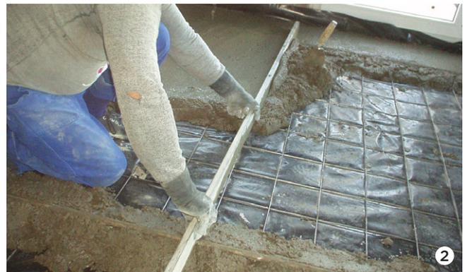
2. Cubrir con un polietileno de 100 micrones solapado >10 cm protegiendo toda la superficie de lana de vidrio (Panel PF y zócalo de lana de vidrio). Incorporar una malla de 10x10 Ø 4 mm instalada con separadores para que quede lo más centrada posible en la altura.
